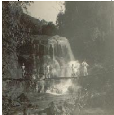
Usina da Queda D'água Banquete
